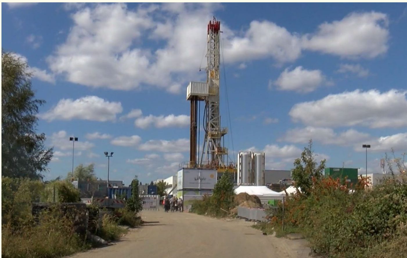
Installation de forage des puits de géothermie à Vélizy-Villacoublay
